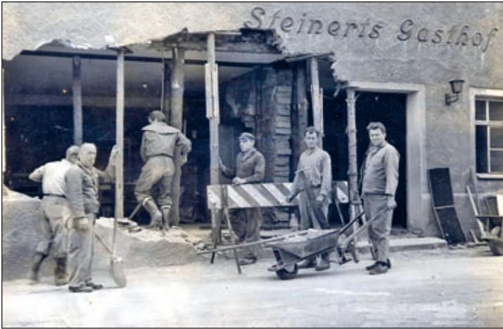
1968. Schadensbeseitigung. v.l.n.r. Fritz Morgenstern, Erich Franke, Günter Hertel, Gottfried Gerstenberger, Günter Schmidt. Heiner Hertel. Foto F.Herbst.
